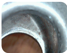
Inwendige schade aan de spanner door onjuiste montage op het tapeind.
